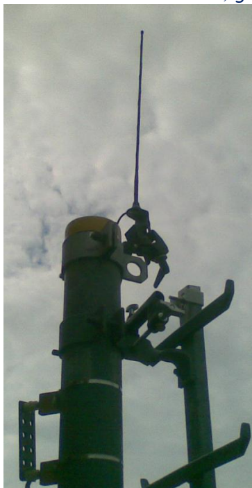
Antenne sectorielle 60° a -3 dB, gain 17 dBi et l'AP Mercury 900 du relais de St Foy Les Lyon
