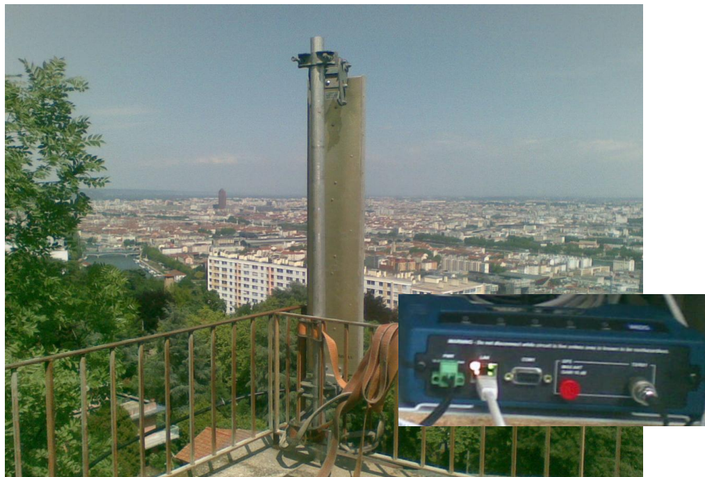
Antenne sectorielle 60° a -3 dB, gain 17 dBi et l'AP Mercury 900 du relais de St Foy Les Lyon
